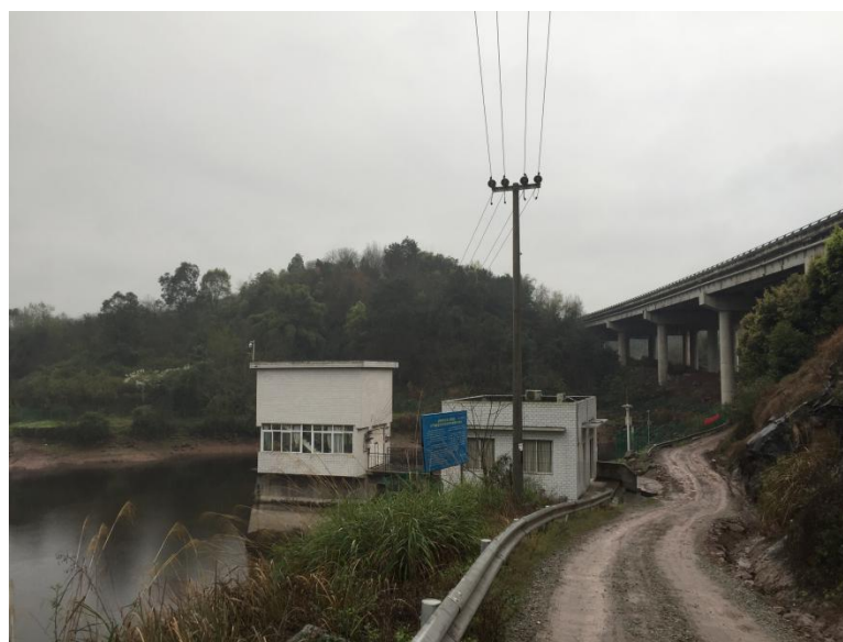
迎龙湖水源地旁的高速公路道桥
