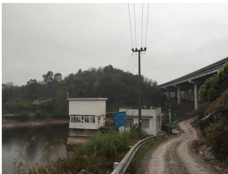
迎龙湖水源地旁的高速公路道桥
